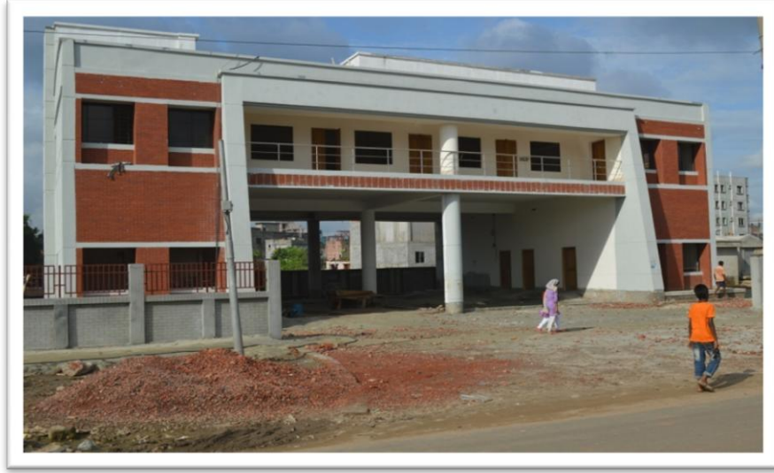
বাস্তবায়নাধীন দেশের গুরুত্বপূর্ণ উপজেলা সদর/স্থানে ১৫৬টি ফায়ার সার্ভিস ও সিভিল ডিফেন্স স্টেশন স্থাপন প্রকল্পের অধীনে নির্মিত স্টেশন
