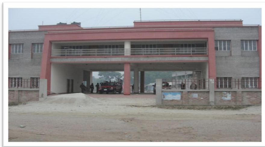
২০১৭-১৮ অর্থবছরে সমাপ্তকৃত দেশের গুরুত্বপূর্ণ উপজেলা সদর/স্থানে ৭৮টি ফায়ার সার্ভিস ও সিভিল ডিফেন্স স্টেশন স্থাপন প্রকল্পের অধীনে নির্মিত স্টেশন
